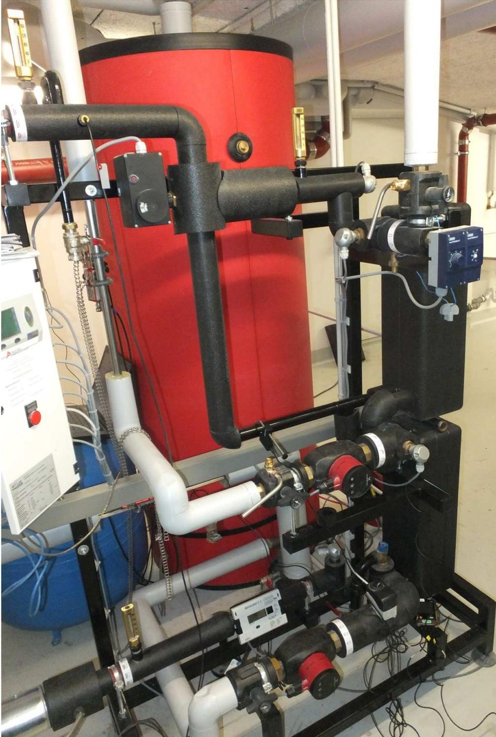
Abb. 3.131 Zweistufiges Speicherladesystem nach FÜS6 in MFH 20
