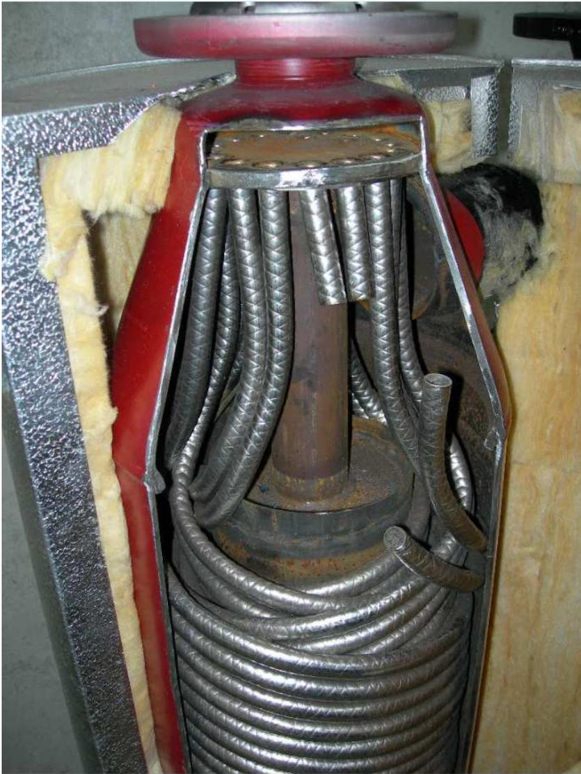
Abb. 3.48 Einblick in den als Vorwärmstufe genutzten Rohrbündelwärmetauscher (FÜS2)
