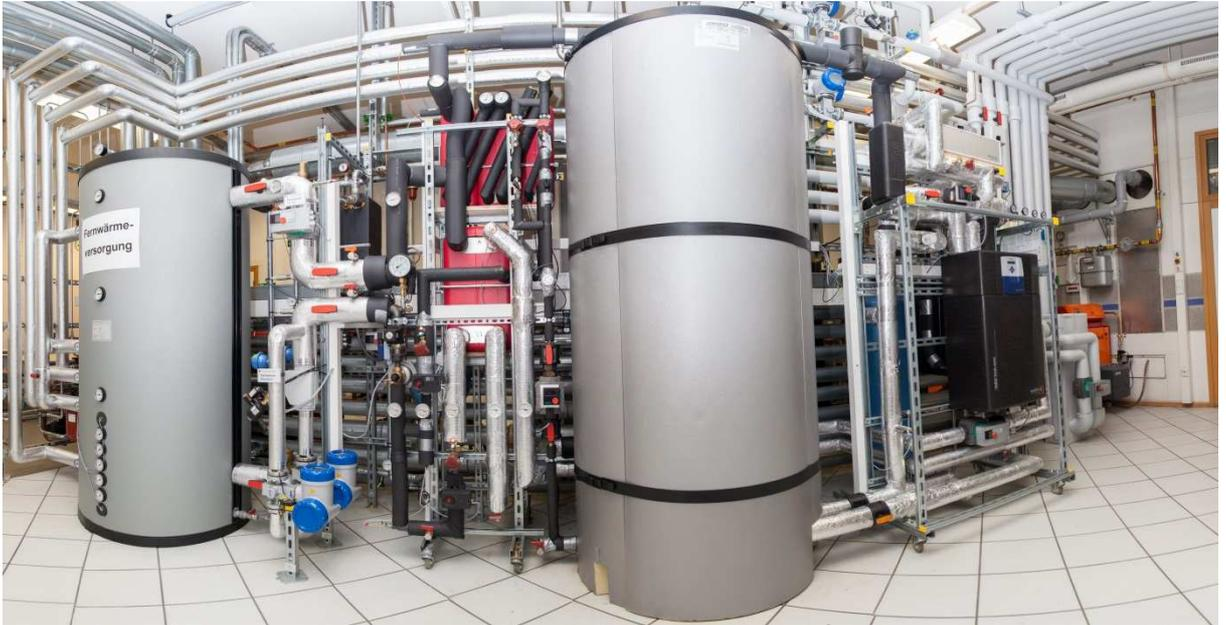
Abb. 3.49 „Panoramaansicht“: Heizungspufferspeicher und Frischwassersystem (FÜS3)
