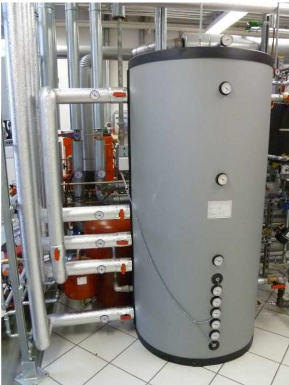
Abb. 3.35 Mehrstufige Beheizung des Fernwärmespeichers durch die beiden Gaskessel
