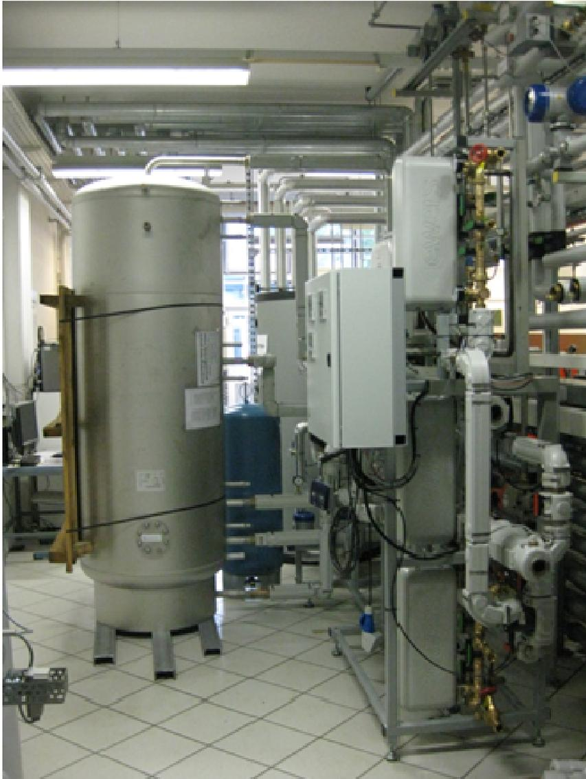
Abb. 3.62 Aufbau der Punef-Schaltung (Heizungspufferspeicher mit innenliegendem Rohrbündel)
