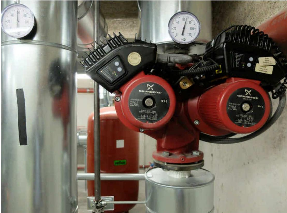
Abb. 4.24 Zubringerpumpen zwischen Wärmetauscher und Verteiler
