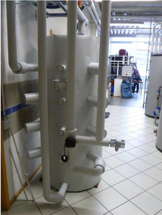
Abb. 3.38 Rückkühlpufferspeicher für Heizung und Zirkulation
