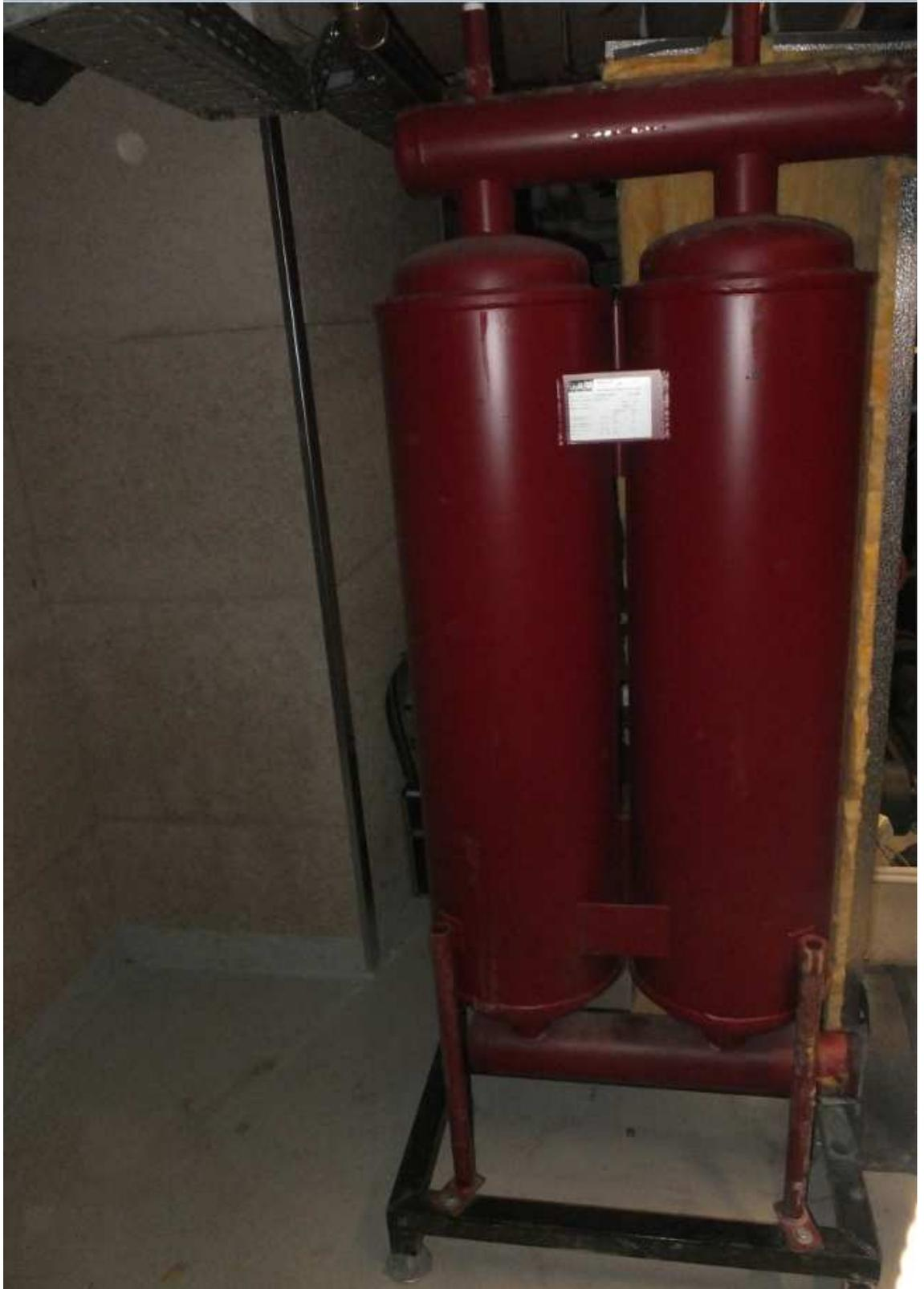
Abb. 5.17 Zwillings-Rohrbündel-Wärme-Übertrager als massebehaftete Vorwärmestufe in Übergabestation MFH 85a „Alte Ziegelei“
