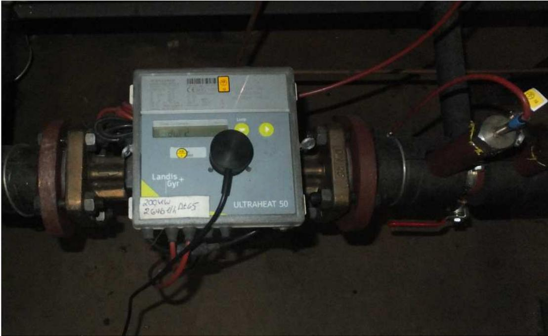
Abb. 4.4 Optokoppler auf eingebautem Wärmemengenzähler UH 50
