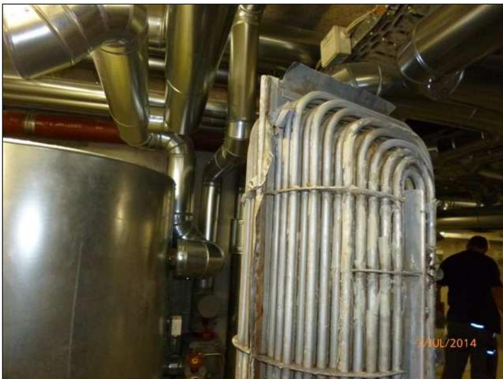
Abb. 4.28 Verkalktes U-Rohr-Heizbündel des Wärmetauschers zur Trinkwassererwärmung
