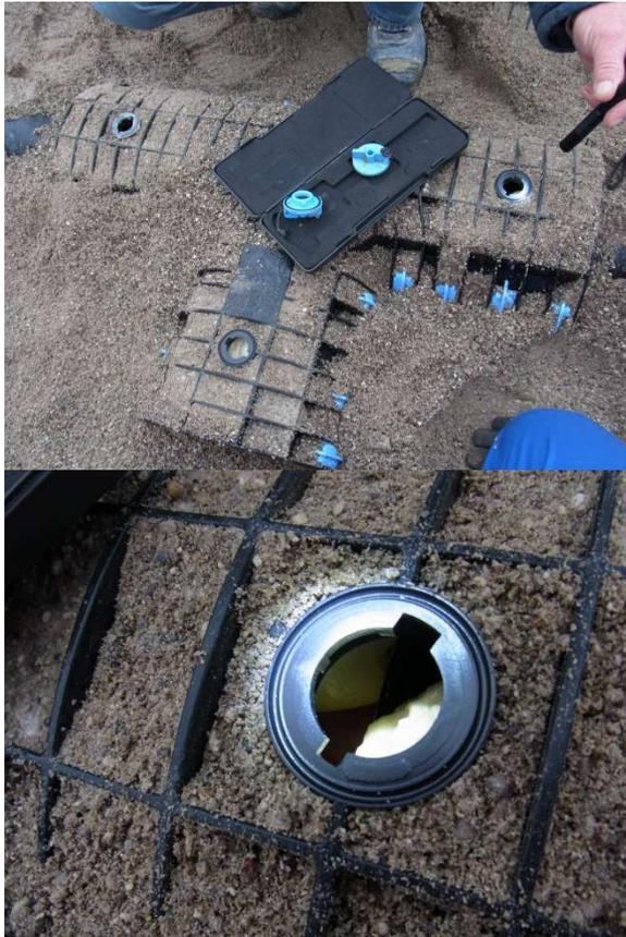
Abb. 5.13 Mangelhafte Ausschäumung eine T-Muffe 75/32/75 (2 Bilder)
