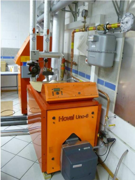
Abb. 3.34 Wärmeerzeuger für die Fernwärmeversorgung (Hochtemperaturheizkessel im Vordergrund sowie Gasbrennwertgerät im Hintergrund)
