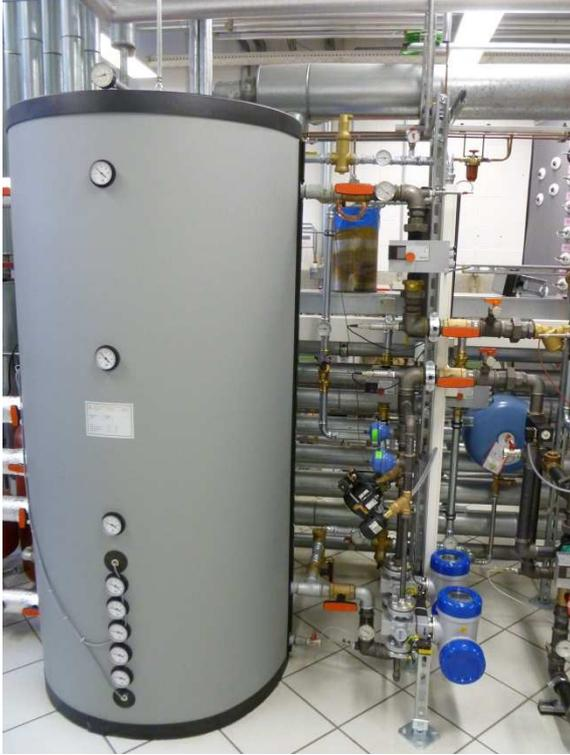
**Abb. 3.36 Fernwärmeanschluss für die zu prüfenden Fernwärmeübergabestation**
