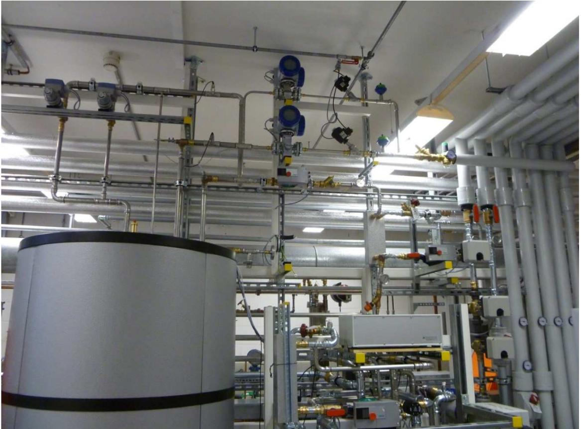
Abb. 3.37 Trinkwasseranschluss, Trinkwasserentnahme (Ventile links oben), Zirkulationsrückkühlung und Heizkreis (rechts)
