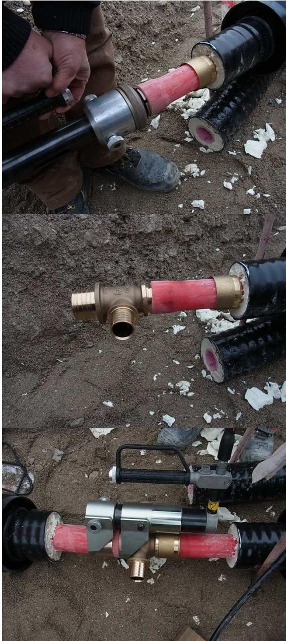
Abb. 5.11 Montagevorbereitung T-Abzweig
